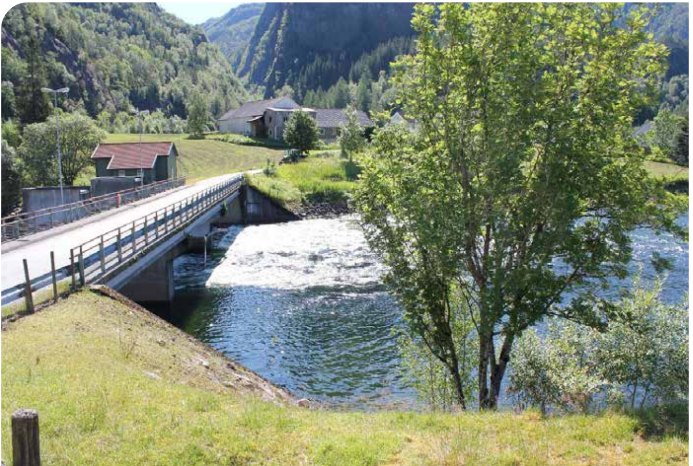
Suldalslågen ved utløpet av Suldalsvatnet, ved Osvad. Hovedvassdraget kalkes via doseringsanlegget som ses på andre siden av broa, med rødt tak.
