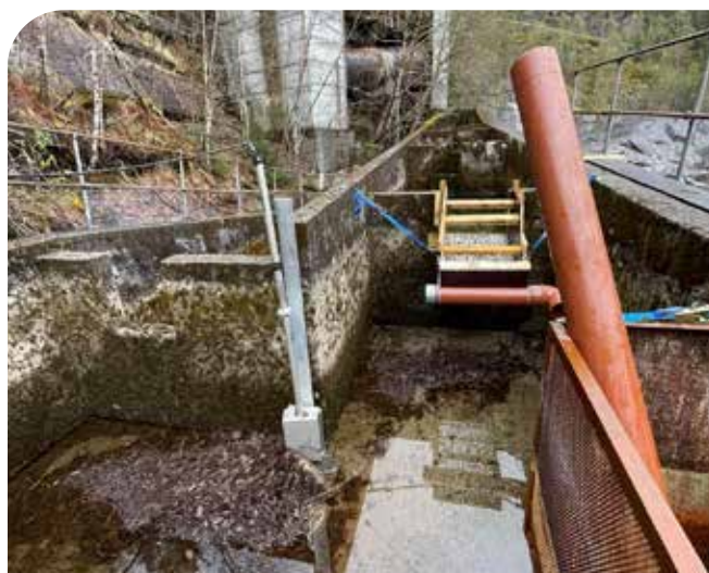
Wolffella ferdig montert i fisketrappa i Hellandsfossen. Foto: Eirik S. Normann, NORCE LFI.
