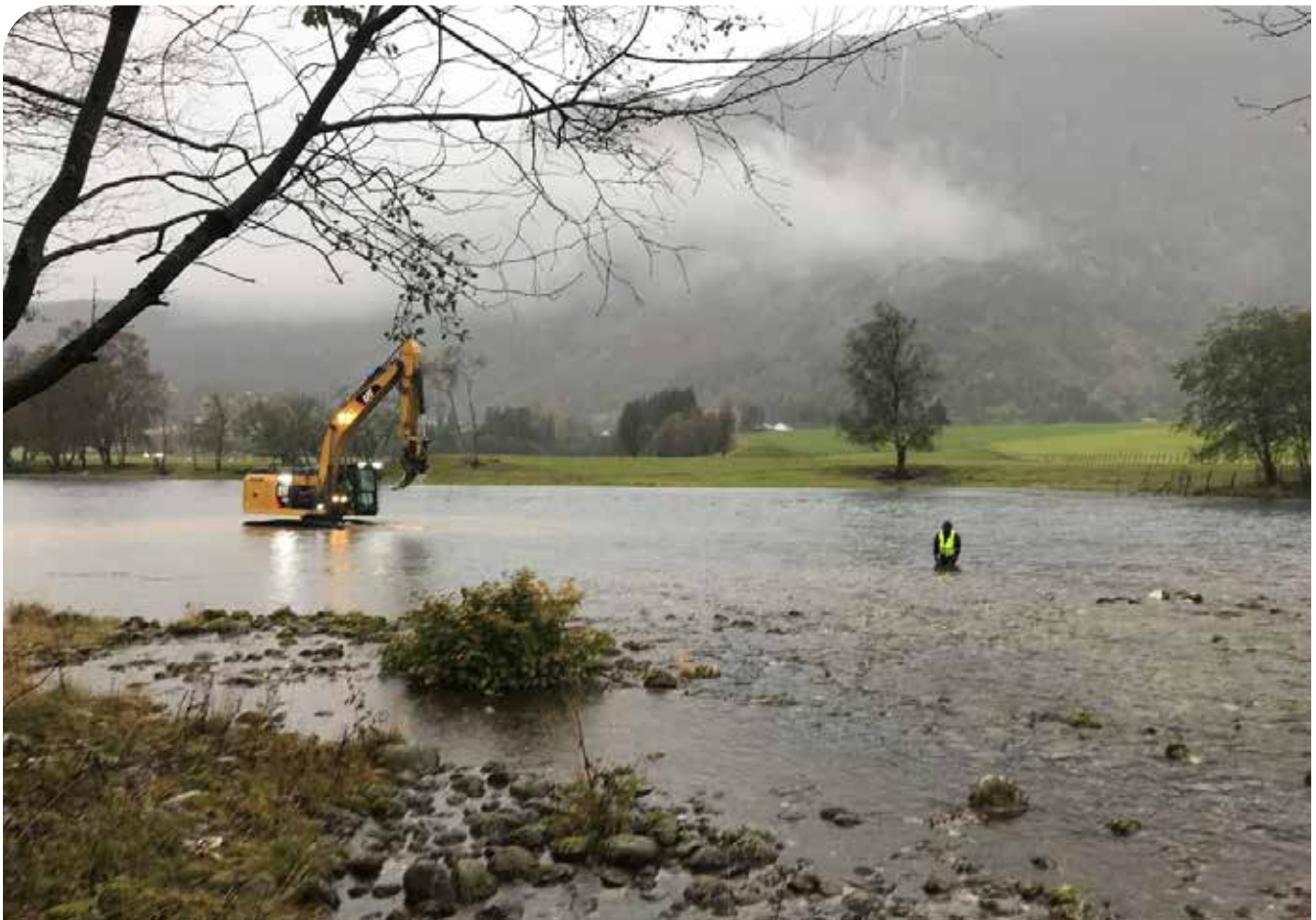
For å kunne rippe et område med elvebunn så må man ha tilgang for gravemaskin. Det har man i grunnere partier av elva, som her. Foto: NORCE LFI.
