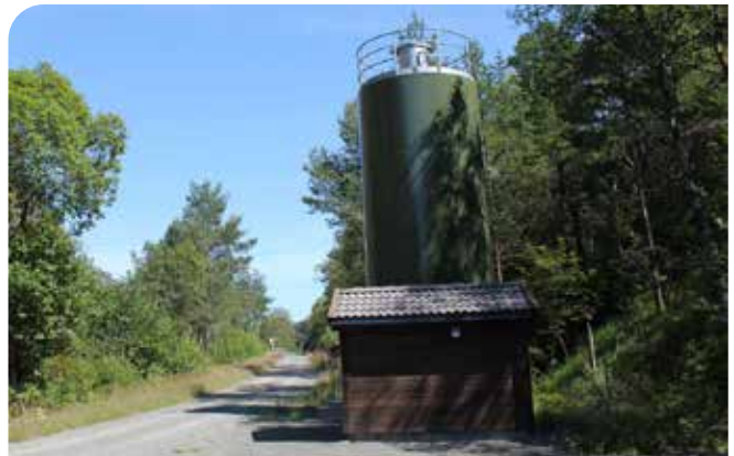
Det vil være behov for kalking av laksevassdragene i Agder i mange år framover, som her i Sira. Bildet viser kalkingsanlegget, som er ett av de siste som er bygget i Agder.
