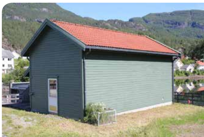
Kalkdosereren ved Osvad. Herfra kalkes hovedelva.
