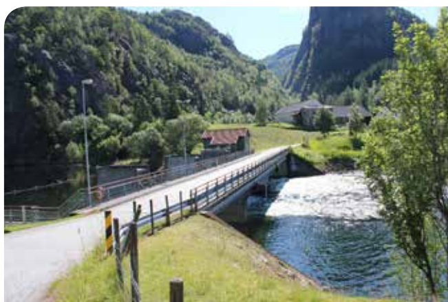
Osvad ved utløpet av Suldalsvatnet. Herfra slippes minstevannføringen til vassdraget, og hovedelva kalkes ved doserer som sees på motsatt side av brua.
