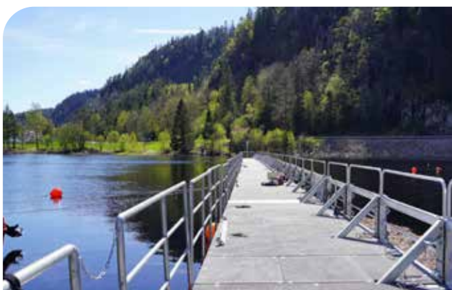
Ledegjerdet ved inntaket til Laudal kraftverk i Mandalselva. Foto: Juliet Landrø/HydroCen.
