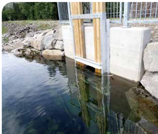
Det nye inntaket til Førlandskanalen. Foto: NORCE LFI.
