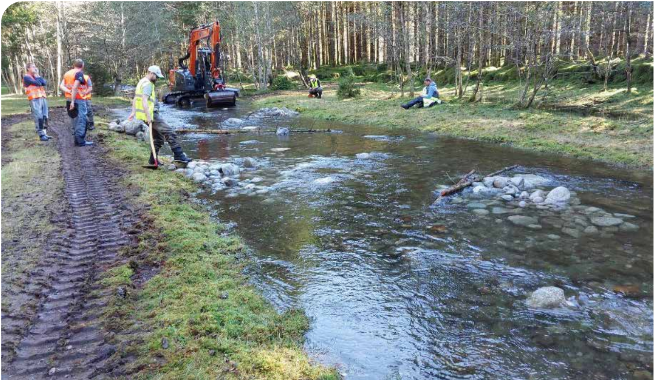
Utlegging av grovere steinmasser samt trestammer for å gi skjul for fisk var et av tiltakene i som ble utført i Førlandskanalen. Foto: NORCE LFI.
