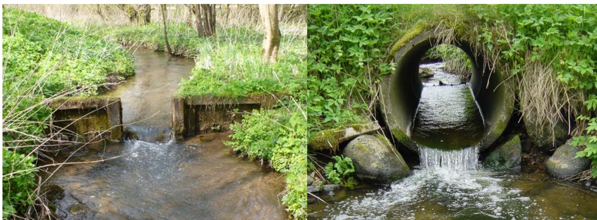
Udlægning af gydegrus kan forbedre passageforholdene mange steder, hvor små styrt og vejundorføring forhindrer, at faunaen kan foretage naturlige vandringer opstrøms.
