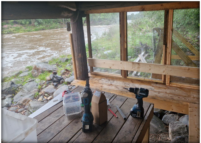
Nye vinduer i Moavika
