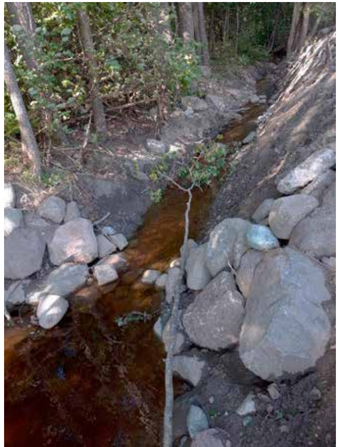
Den nyåpnede delen av bekken etter steinsetting og tilførsel av gytegrus.
