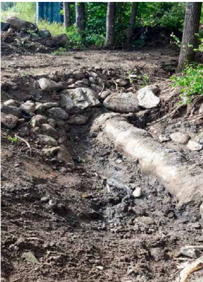
Fremgraving av rørlagt bekk
