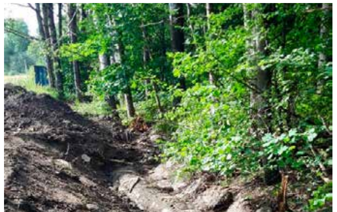
Fremgraving av rørlagt bekk
