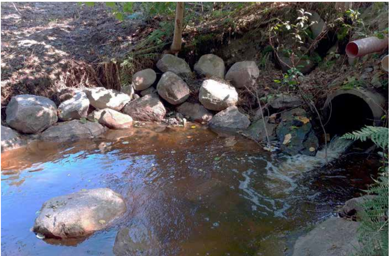
Etter stensetting, erosjonen stanses, og vannspeilet heves opp mot røret
