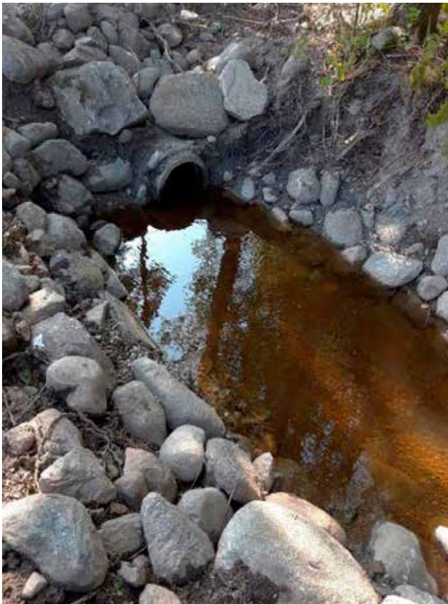
Den nyåpnede delen av bekken etter steinsetting og tilførsel av gytegrus.
