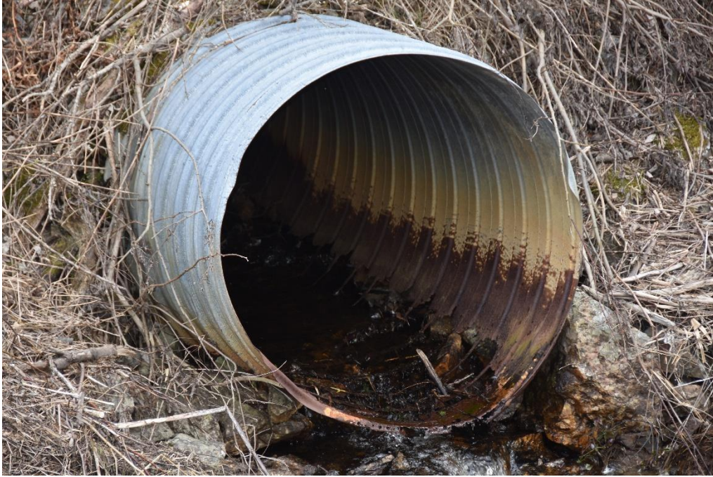
Figur 7 Istykkerrustet rør.
