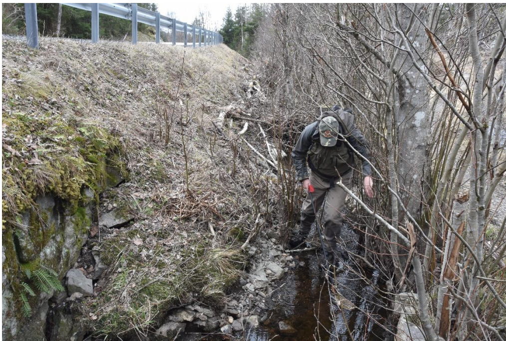
Figur 8 Mellom veien og tett, men smal, kantvegetasjon.
