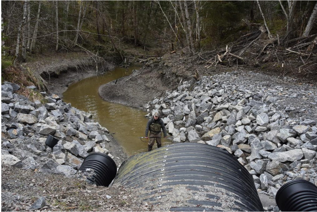
Figur 5 Både rørdimensjon og fyllmasser vitner om at bekken kan gå riktig stor til tider.
