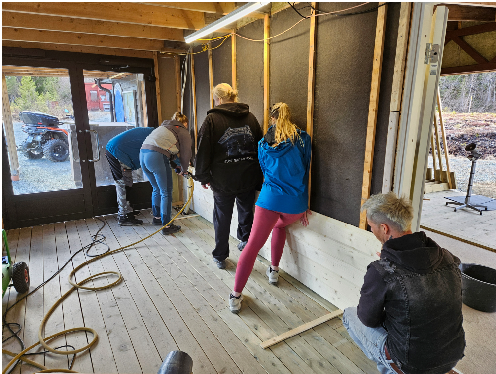
Paneling av veggen i oppholdsrommet på Bane 1.
